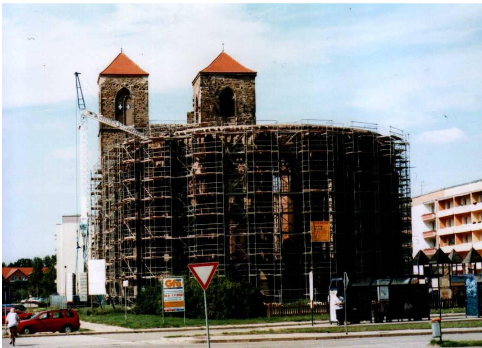
In voller Rüstung: Mauerkronensicherung mit Begrünung 2002
